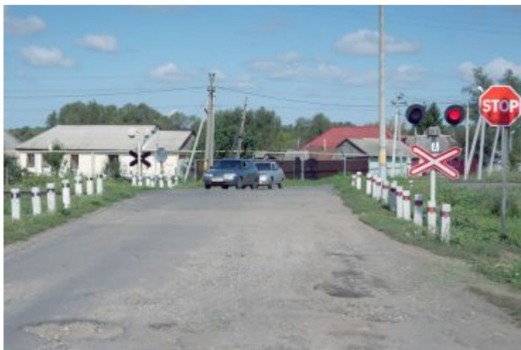
Регулируемый ж/д переезд на дороге по ул. Вокзальная в п. Кшенский
